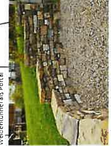
Trockensteinmauer Quarzandstein Plattselb Sitzgelegenheit, Lebensraum und als Raumgliederndes Element
